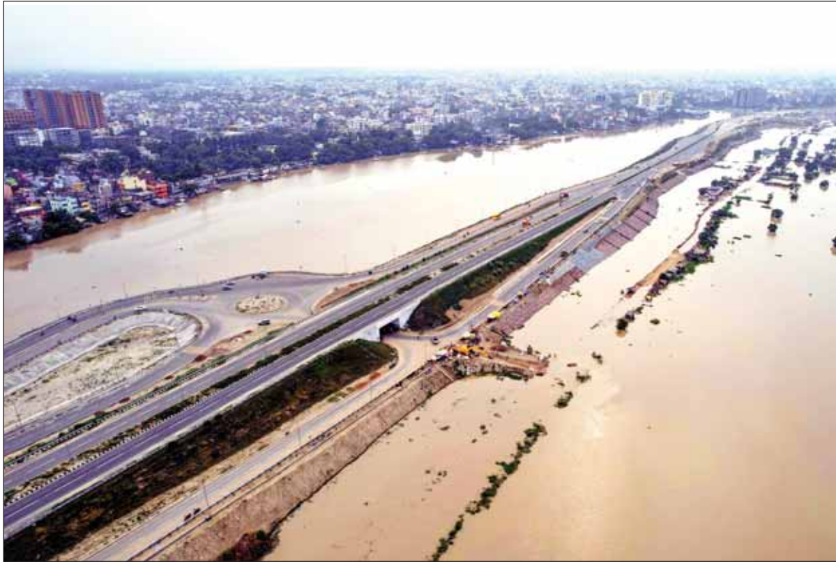
पाटना में मंगलवार ३० अगस्त को नदी का जल स्तर लगातार बढ़ ने से गंगा नदी के तट पर मरीन ड्राइव पर पानी भर गया
